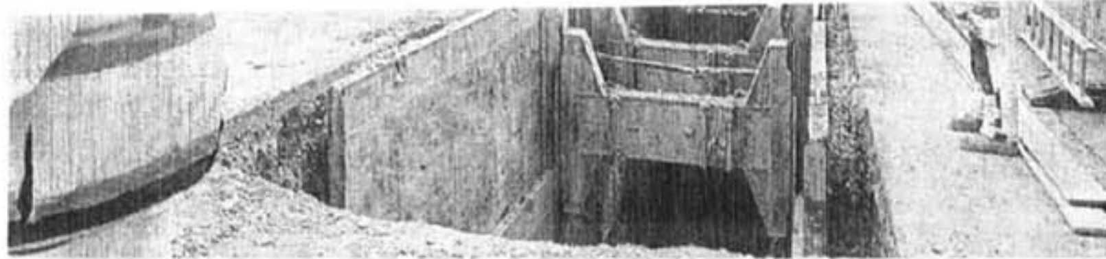
Es geht voran: Die Kanalarbeiter sind noch immer in Hanfeld, so wie hier an der St.-Michael-Straße, aktiv, bis Sommer soll dieser Teil der Arbeiten abgeschlossen sein. FOTO: SVJ
